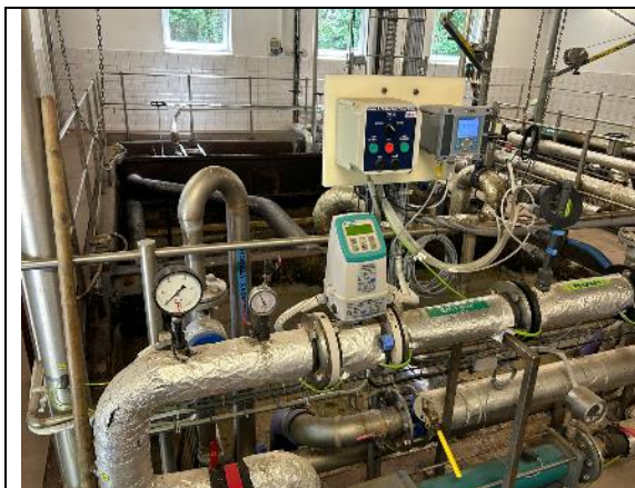
Stávající stav objektu
