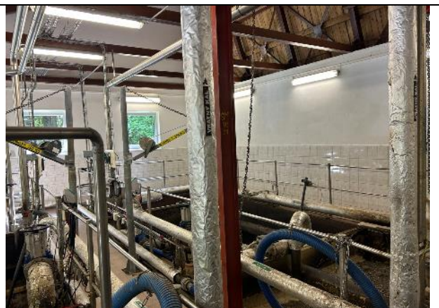
Stávající stav objektu
