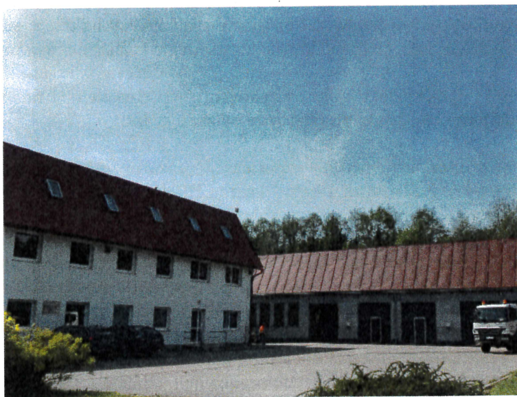
Provozní středisko SČVK a.s. v Jilemnici – sídlo provozovatele pro náš region.
