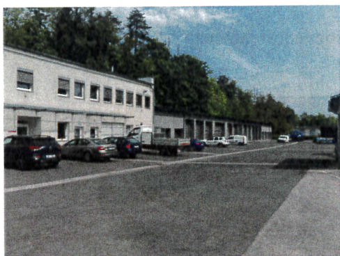
Provozní středisko v Turnově.
