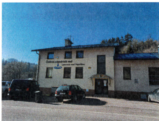
Provozní středisko v Lomnici nad Popelkou
