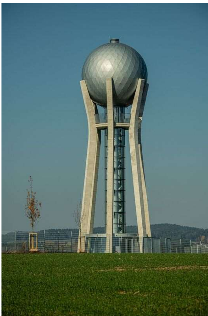
Úspěšná a oceněná stavba - věžový vodojem v Ohrazenicích.
