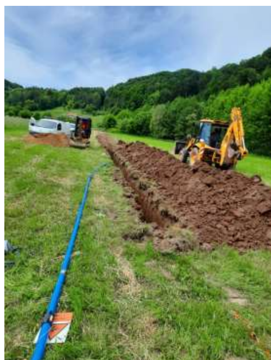
Rakousy – oprava vodovodu
