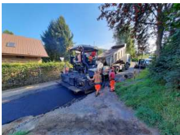
Benešov u Semil - asfaltování po stavbě vodovodů
