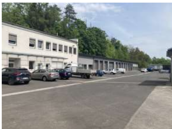
Provozní středisko v Turnově.
