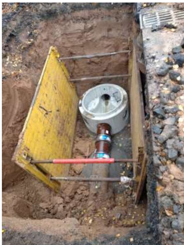
Jilemnice – oprava kanalizace
