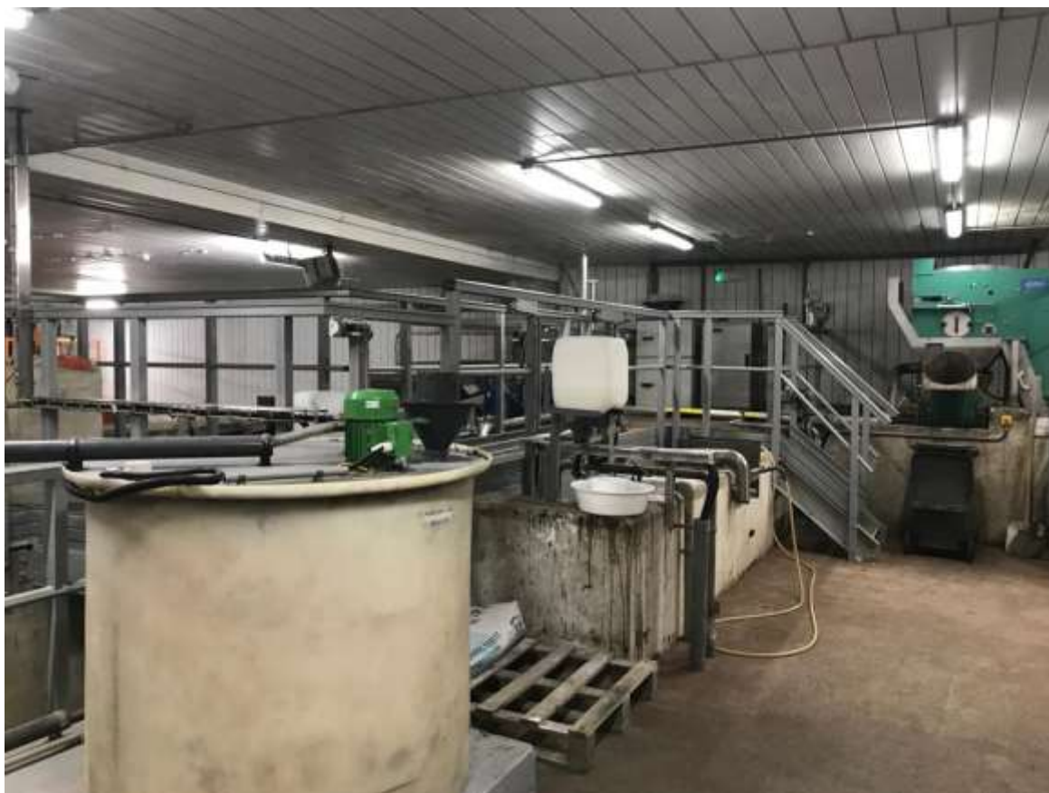
Vzadu - strojně stírané česle a nový lis na shrabky
