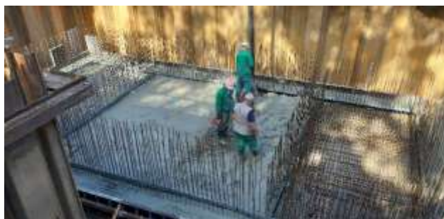
Foto: betonáž základové desky pod ČOV
