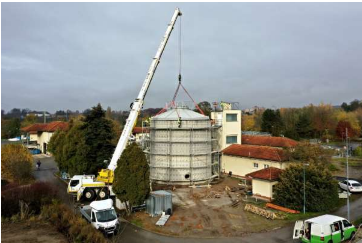
Vyhnívací nádrž – montáž vrchlíku
