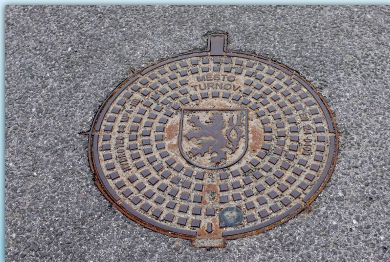
Kanalizační poklop - pod ním se skrývá kanalizační šachta, která navazuje na kanalizační potrubí pod zemí.
