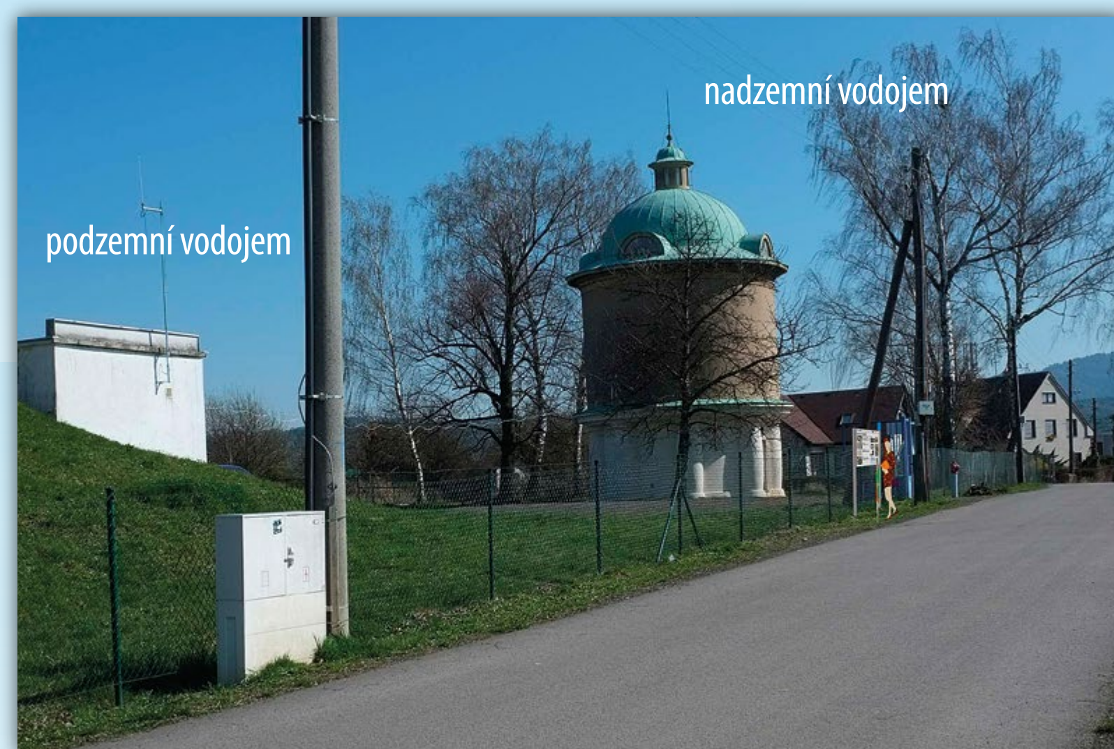
VDJ Károvska 2 x 300 m 3 , 1 x 1 000 m 3 , věžový 160 m 3
