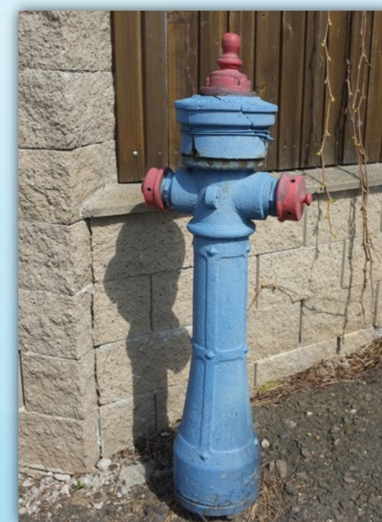
Nadzemní hydrant - u dalšího zastavení u vodojemů si všimněte nadzemního hydrantu. Vodovodní hydranty mohou být nadzemní i podzemní. Slouží k odebrání vody z vodovodní sítě (hasiči, atd.), k odkalení vodovodu nebo k jeho odvzdušnění.
