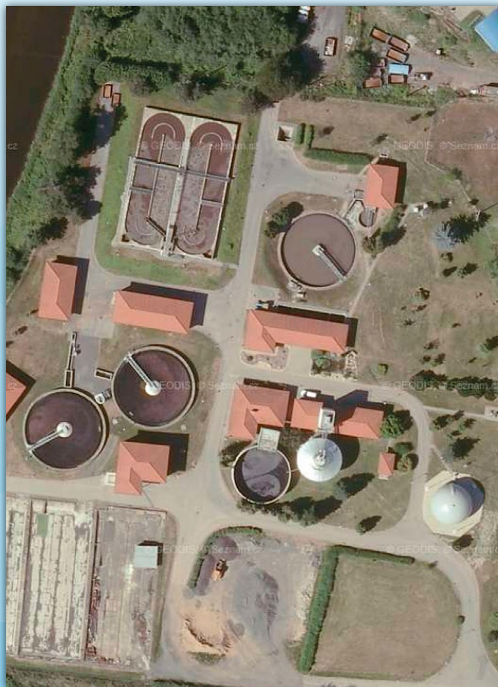
Čistírna odpadních vod (ČOV) Turnov
