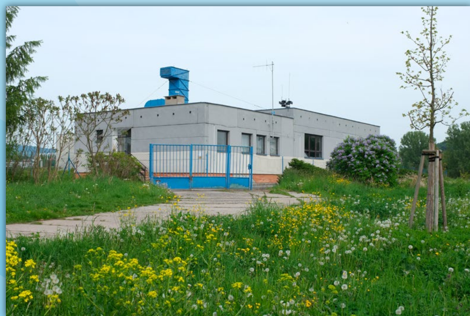
Úpravna vody - Nudvojovice
