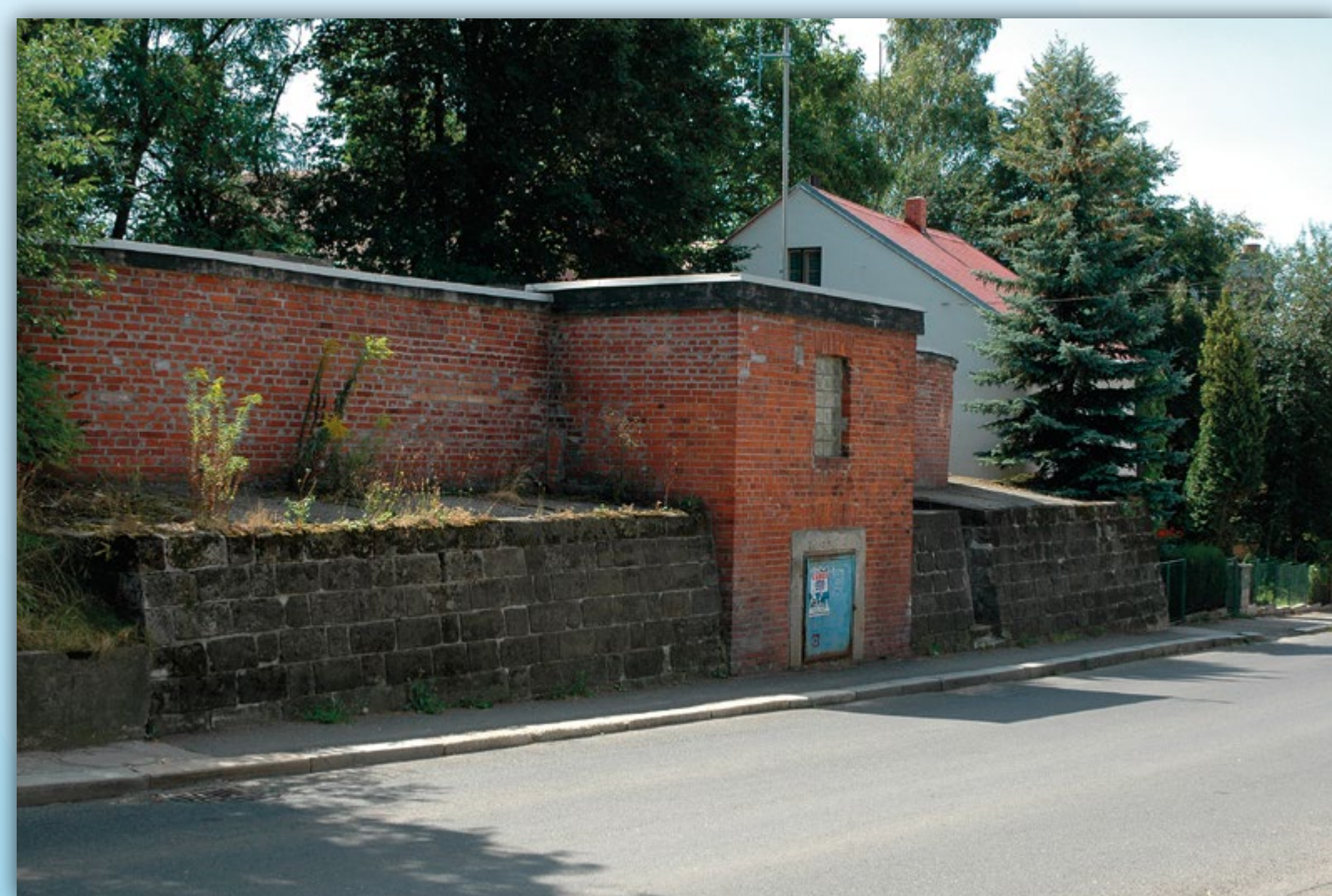
VDJ Hrušnice na ulici 5. května - 350 m 3
