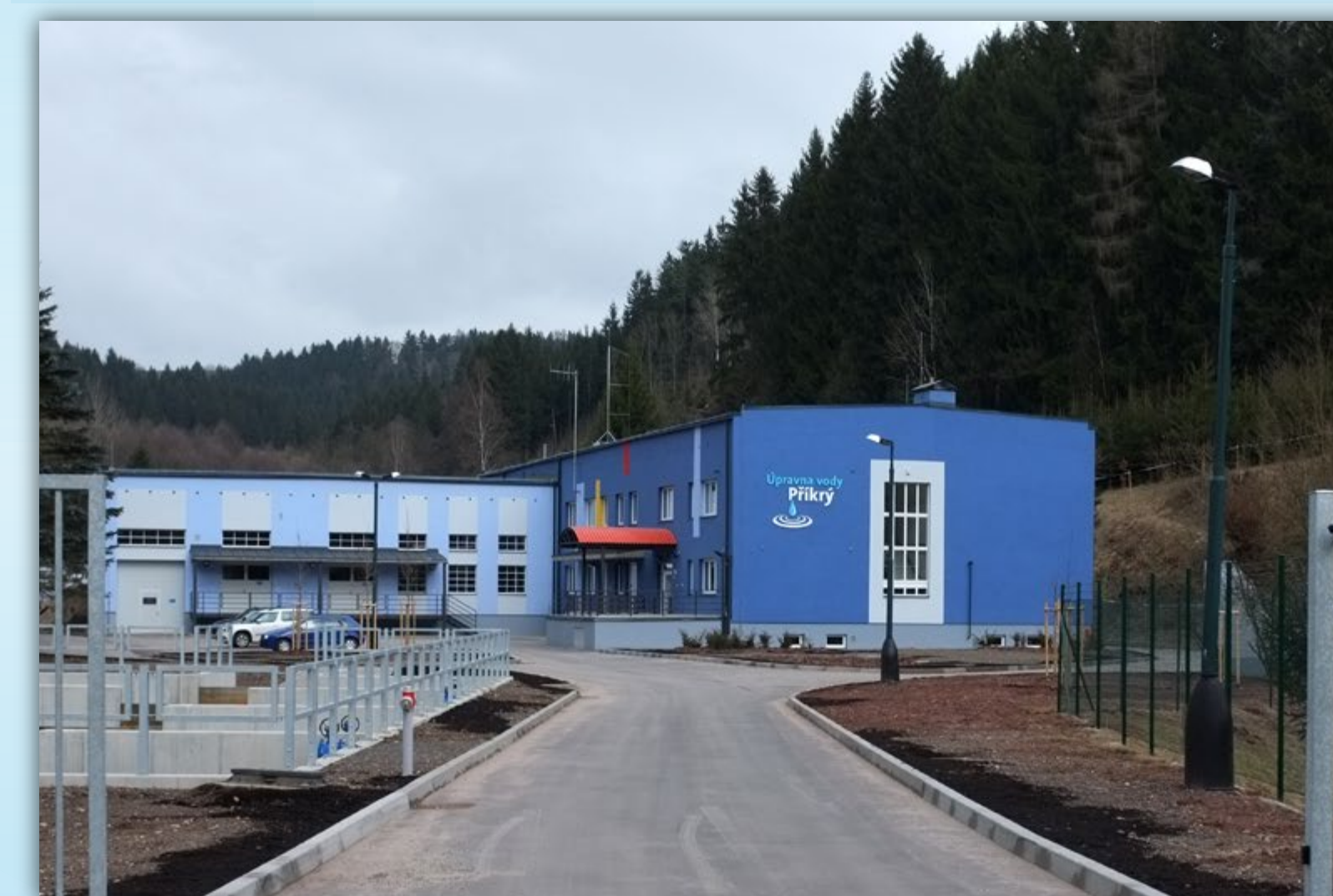
Úpravna vody - Příkrý na Semilsku
