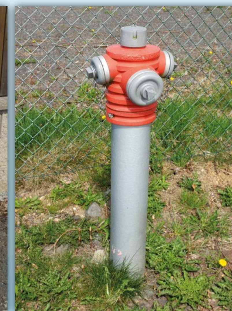
Nadzemní hydrant - u dalšího zastavení u vodojemů si všimněte nadzemního hydrantu. Vodovodní hydranty mohou být nadzemní i podzemní. Slouží k odebrání vody z vodovodní sítě (hasiči, atd.), k odkalení vodovodu nebo k jeho odvzdušnění.
